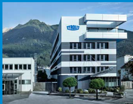
Hoofdkantoor van TYROLIT in Schwaz (Oostenrijk)
