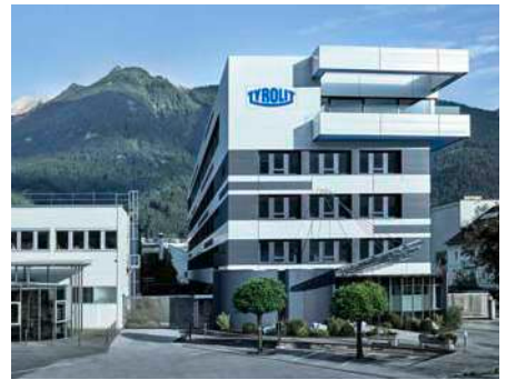
Hoofdkantoor van TYROLIT in Schwaz (Oostenrijk)
