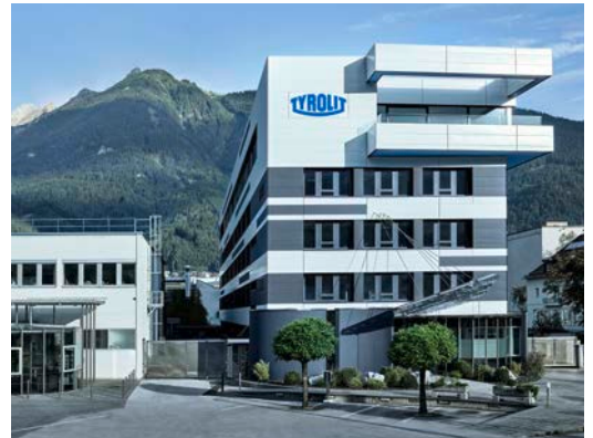
泰利莱总部位于奥地利的施瓦茨
