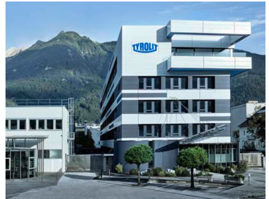
TYROLIT hoofdkantoor in Schwaz, Oostenrijk.
