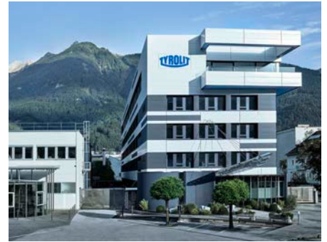
Hoofdkantoor van TYROLIT in Schwaz (Oostenrijk)
